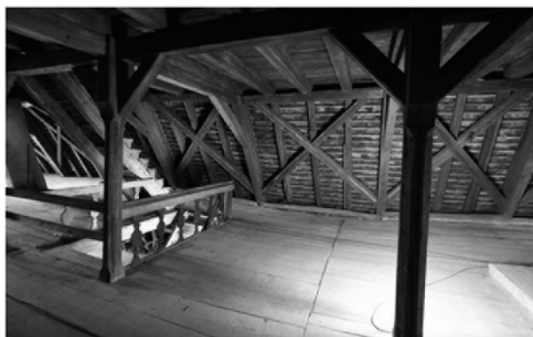
Figure 1 : La charpente au deuxième niveau des combles
