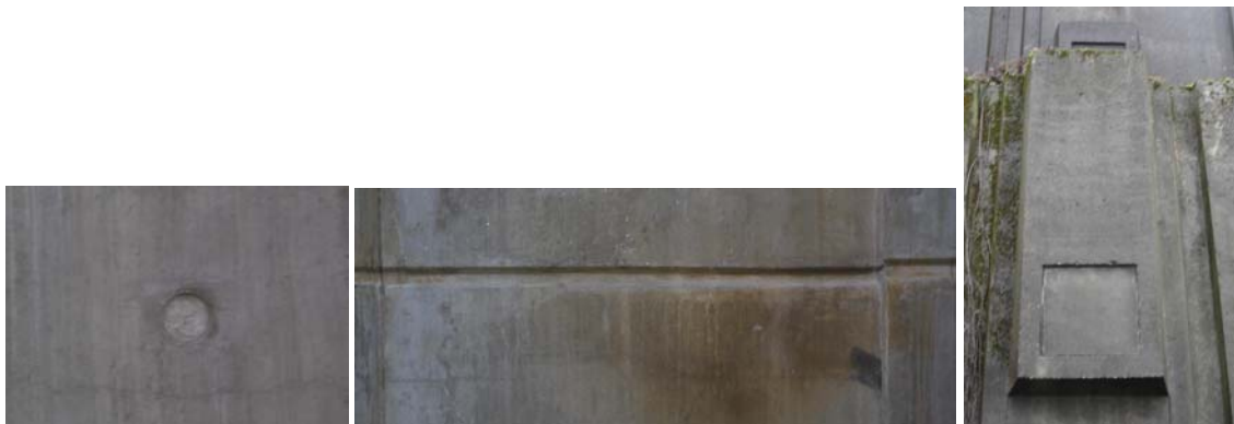
Figure 3 : Eléments caractéristiques identifiables (trou de coffrage, reprise de bétonnage, surface plane et arête)
