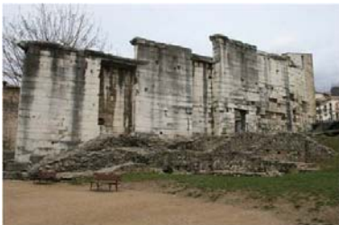
Figure 1 : Photographie du Mur Nord de l'Assemblée. Février 2007. TPLM-3D.
