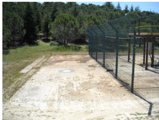
Figure 7: Dalle en béton servant de cible dans la zone de subsidence
